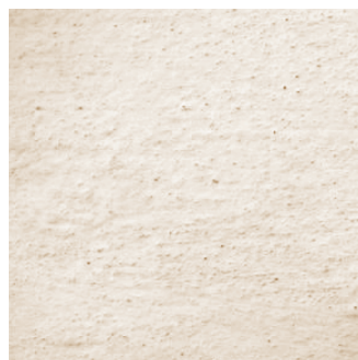
Puts i ljusgul
